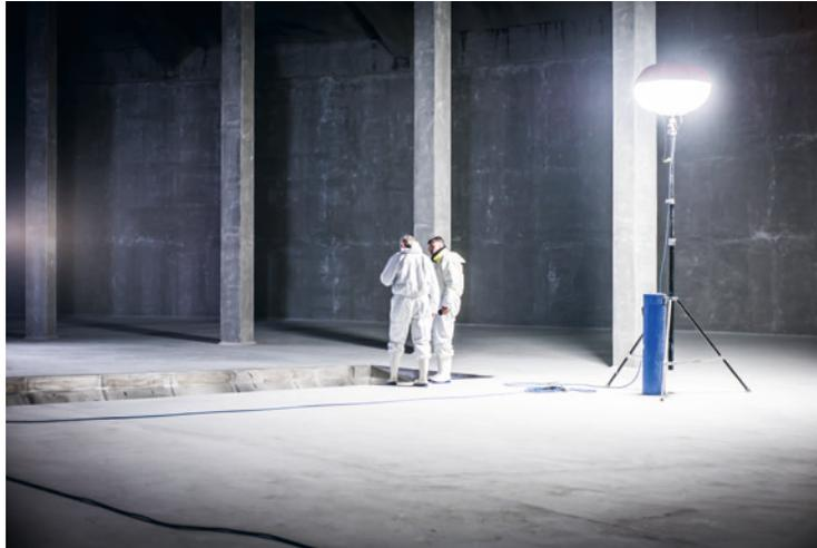
Frisch instandgesetzter Trinkwasserbehälter kurz vor der Wiederinbetriebnahme – höchste Hygienestandards für eine sichere Wasserversorgung
